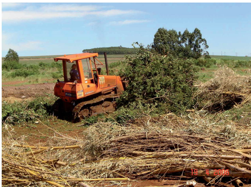
Figura 152 – Compactação dos resíduos de poda e capina no aterro sanitário municipal de Toledo-PR.
