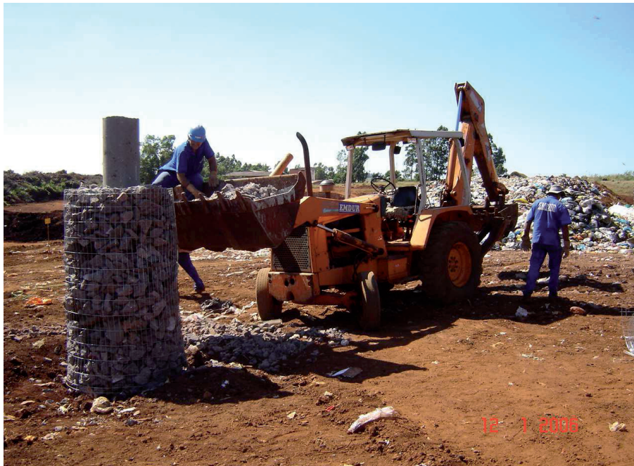
Figura 138 – Construção dos drenos verticais de gases, no aterro sanitário municipal de Toledo-PR.
