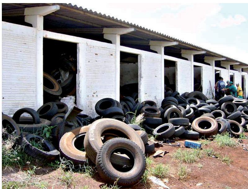
Figura 97 – Vista lateral do galpão que era utilizado para o armazenamento temporário de pneumáticos do Município de Toledo-PR, localizado no Parque Tecnológico de Toledo – Tecnoparque.
