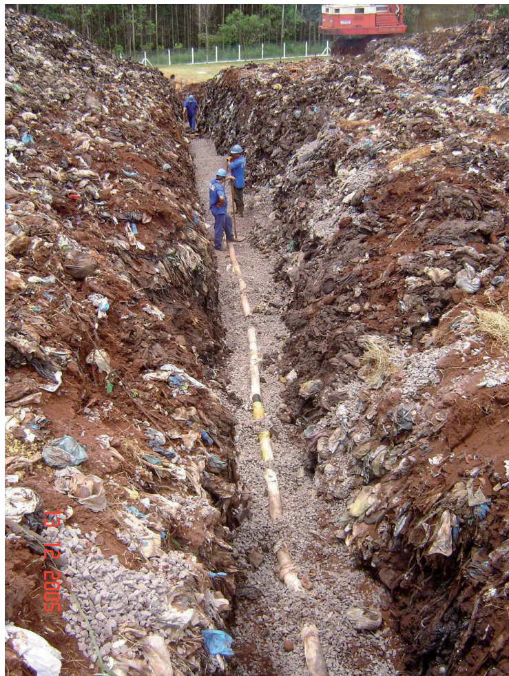
Figura 137 – Recuperação dos drenos horizontais de chorume, no aterro sanitário municipal de Toledo-PR.
