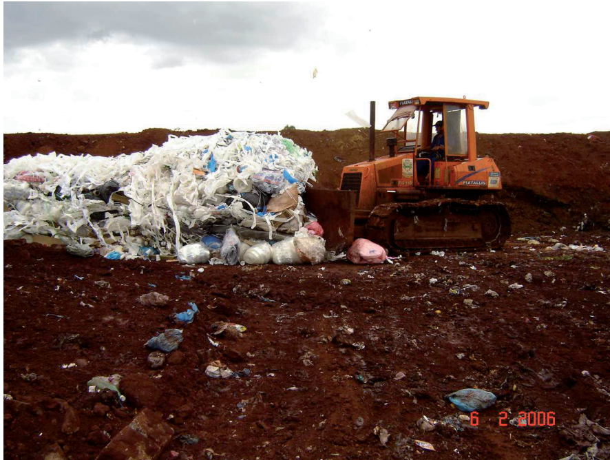
Figura 89 – Compactação dos resíduos industriais no aterro sanitário municipal de Toledo-PR.
