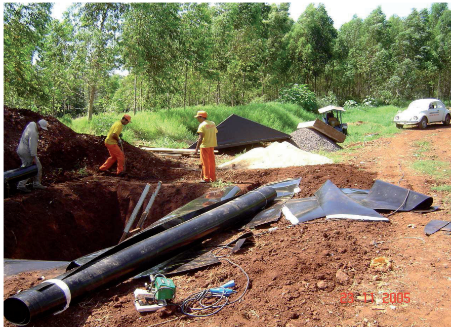
Figura 113 – Construção da vala impermeabilizada para RSS, revestida com geomembrana de PEAD 3,0mm, no aterro sanitário de Toledo-PR.
