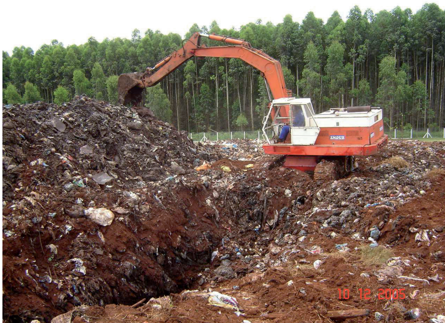
Figura 136 – Obras de recuperação do sistema de drenagem horizontal de chorume, no aterro sanitário municipal de Toledo-PR.
