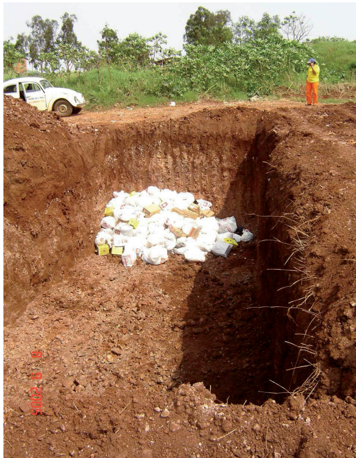
Figura 109 – Vala na qual eram dispostos inadequadamente os Resíduos de Serviços de Saúde - RSS, no aterro sanitário de Toledo-PR.
