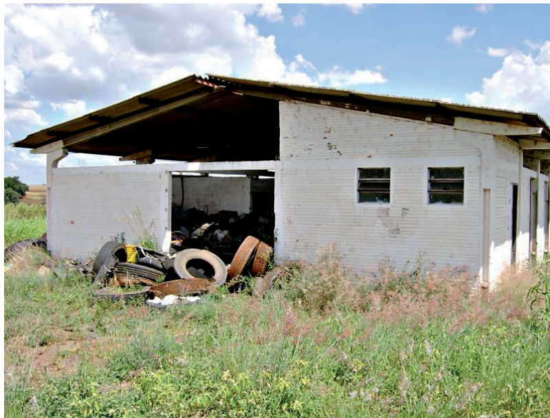
Figura 96 – Galpão utilizado para armazenamento temporário de pneumáticos do Município de Toledo-PR, localizado no Parque Tecnológico de Toledo – Tecnoparque.
