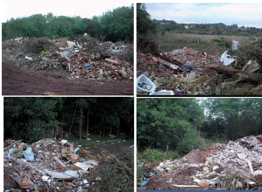
Figura III.43. Fotos de destinação de resíduos em locais inapropriados (bota-fora).
