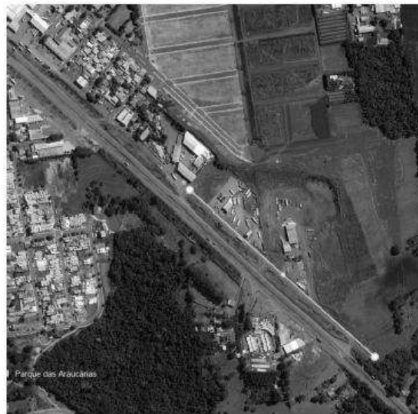
Figura 1 – Rua Presidente Juscelino Kubitschek de Oliveira, compreendendo a trecho entre a EST.33+10,69 e a EST.02+6,43
