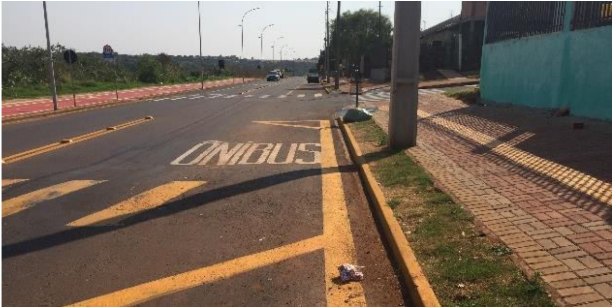
Figura 39 - Exemplo de local de parada de ônibus sem sinalização vertical
