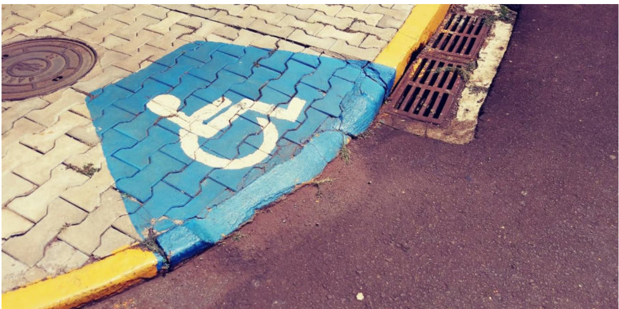
Figura 40 – Calçada com rampa de acessibilidade. Rua Raimundo Leonardi
