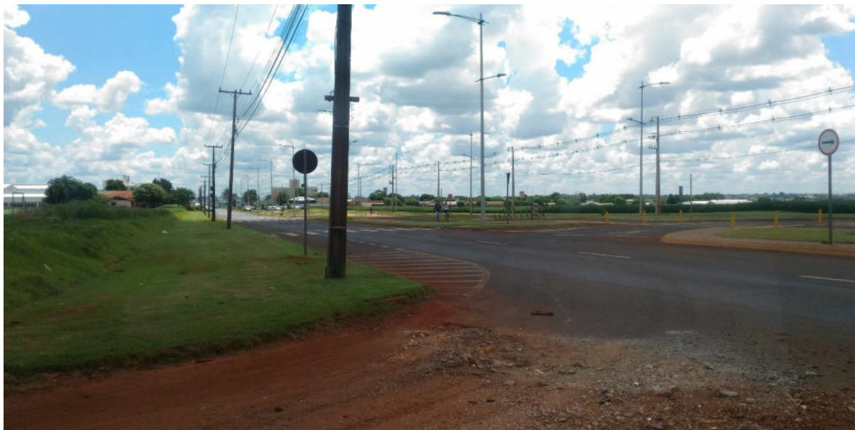
Figura 35 – Avenida Maripá, conexão com a PR-317
