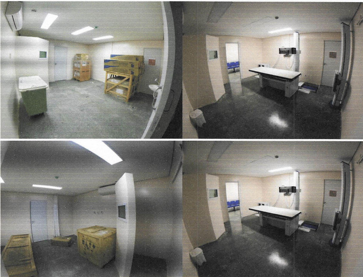
Imagem 11: Sala de Exames 1 e Sala de Exames 2 (Raio X) - Antes e depois
