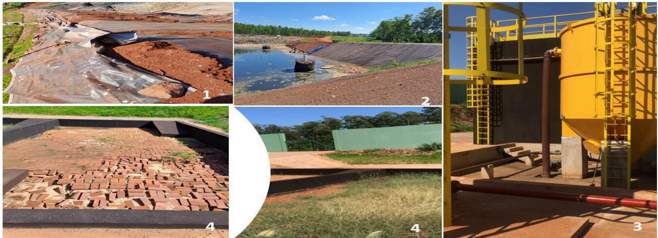
Figura 5. Imagens das estruturas do Aterro Sanitário de Toledo, 2025.
